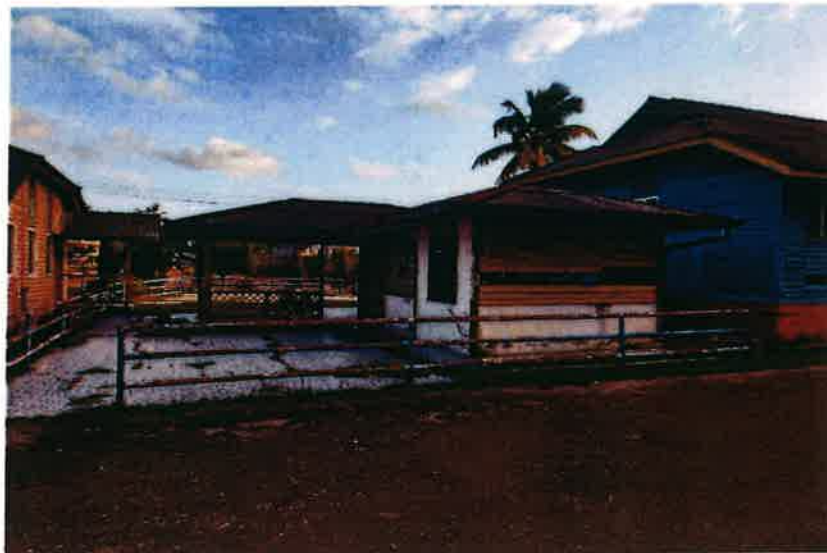
Bangunan Taman Rekreasi, Tampin
